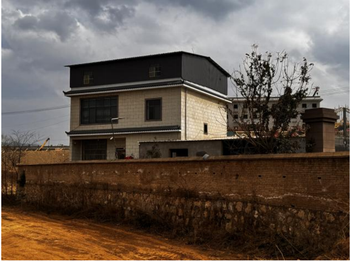
附图 2.12-2 本工程待拆迁建筑
