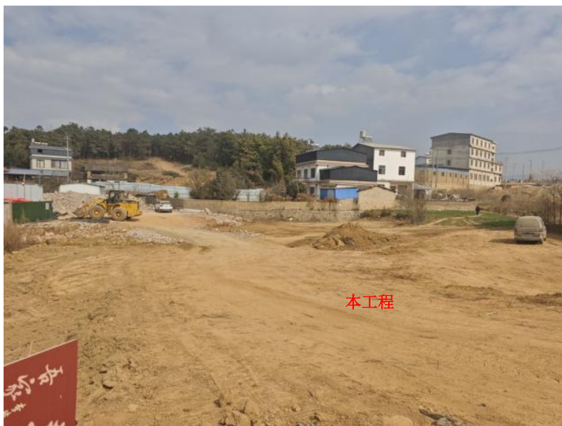
附图 2.13-1 本工程施工现状图
