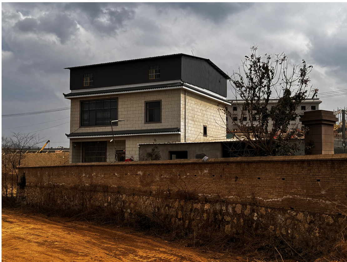
附图 2.12-2 本工程待拆迁建筑
