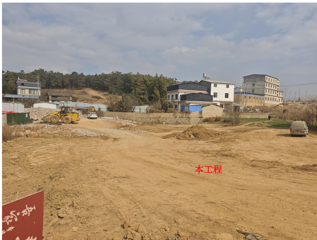
附图 2.13-1 本工程施工现状图
